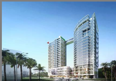
Centre Complexe Aissat 4500 Alger Residence, Commerce et Bureau Livraison 2015
